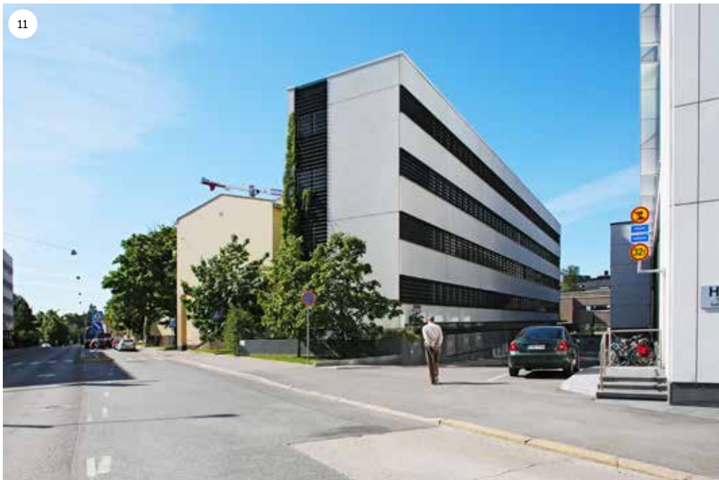
Kesäkuussa 2016 kohti etelää otetussa valokuvassa näkyy keskellä vuonna 2003 valmistunut viisikerroksinen laajennusosa sekä sen vasemmalla puolella rakennuksen vanhan osan C-portaaseen johtava päätyseinää. Laajennusosan arkkitehtuuri poikkeaa sekä massoitteiltaan että materiaaleiltaan vanhasta osasta. Seinät ovat rapattuja ja maalattuja betonielementtiseiniä. Nauhamaisten ikkunoiden edessä on alumiinisäleiköt.
