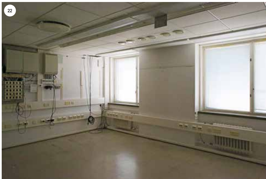
Neljännen kerroksen eteläosa oli alun perin henkilökunnan asutokäytössä. Ennen tyhjentämistä huone 419 toimi työlääketieteen monitorointihuoneena. Huoneeseen on asennettu runsaasti uusia laitteistoja ja sähköasennuksia. Katto on alaslaskettu. Patterit ja ikkunat ovat alkuperäisiä. Lattia on uusittu.
