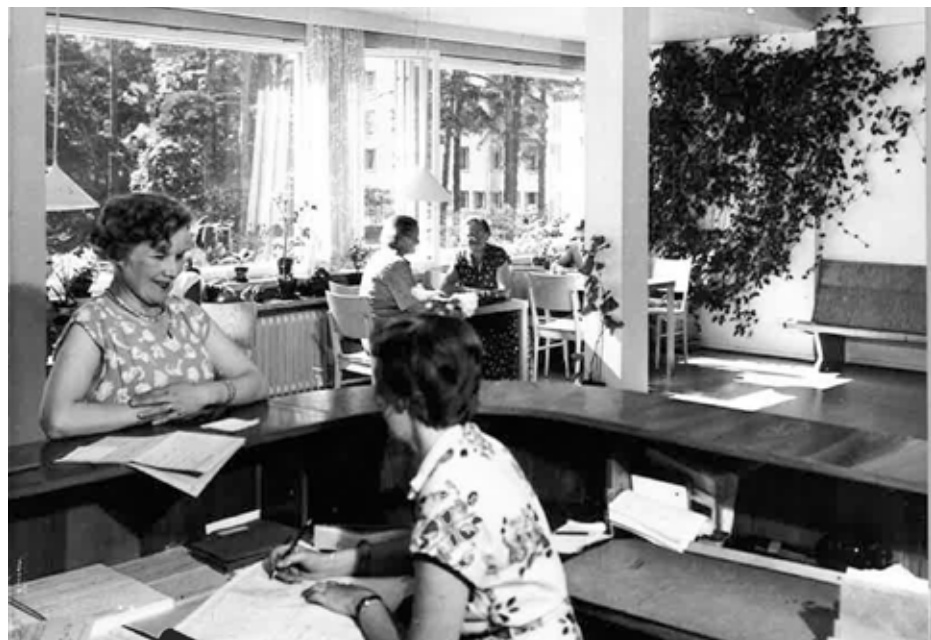
Valoisa toisen kerroksen aulatilaa 1951. TTL.
