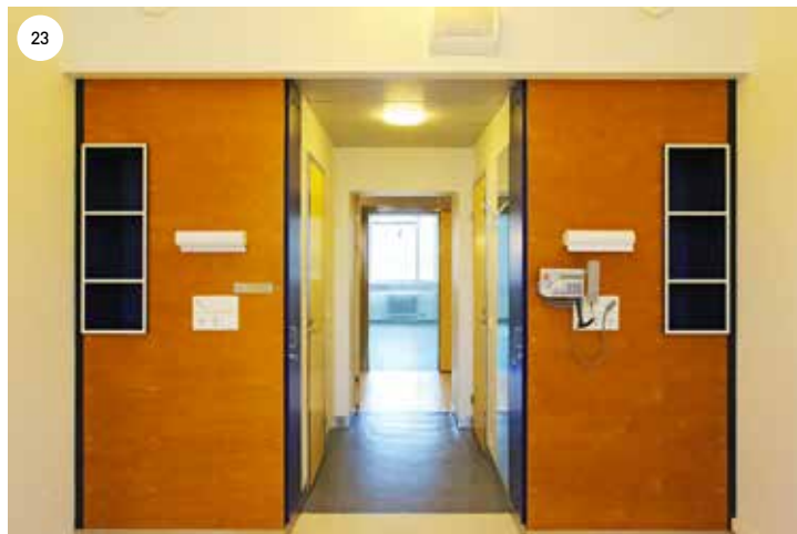
Viidennen kerroksen huone 530 on toiminut vuodeosaston potilashuoneena. Tiloihin ovat kuuluneet erillinen wc ja kylpyhuone, vaneriset kiintokomerot ja varsinainen potilashuone. Huoneen etuosassa on alaslaskettu katto. Lattiat on uusittu 1998. Kaikki huoneen ovet ovat myös uusia laakaovia. Ovien puitteissa on RST-listat.
