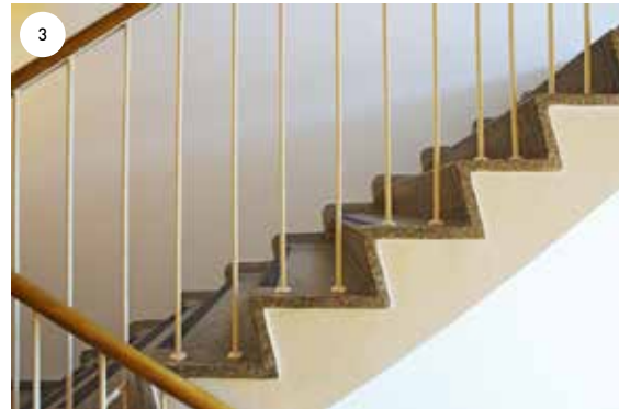
B-porras. Porraskaiteiden profiili poikkeaa suorasta kulmasta.
