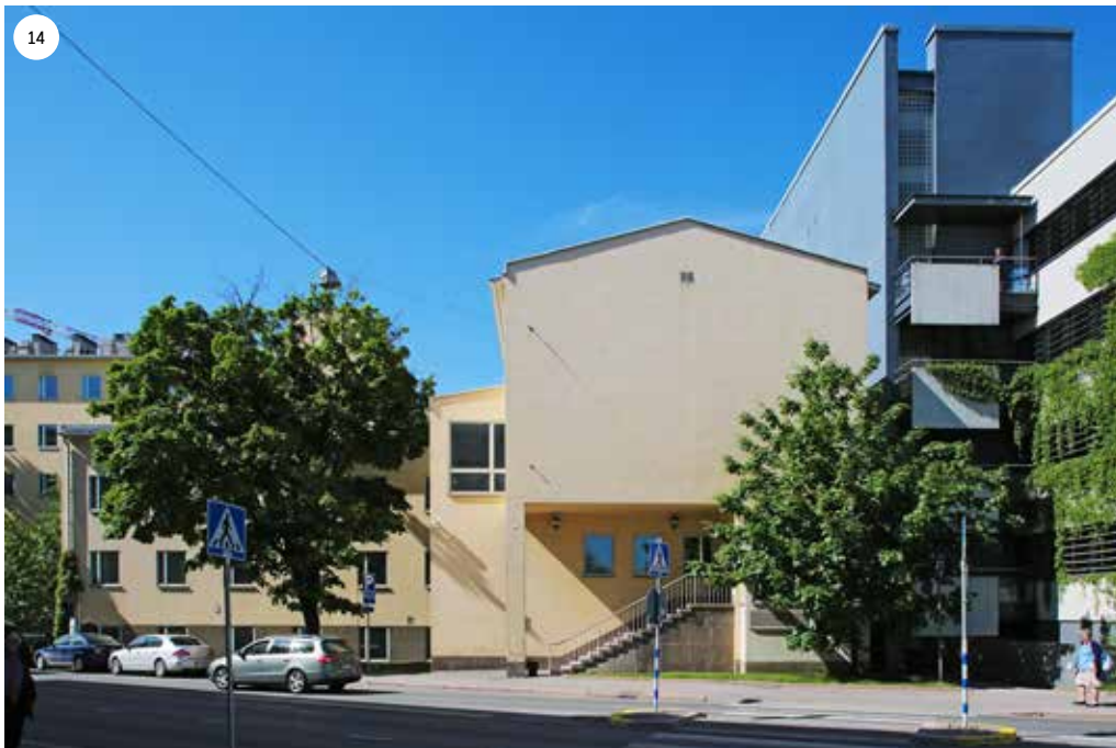
14 Vanhan rakennuksen auditorioon pääsee Topeliuksenkadun puoleisesta sisäänkäynnistä. Vanha rakennus nivoutuu kiinni kuvan oikeassa reunassa olevaan laajennusosaan.
