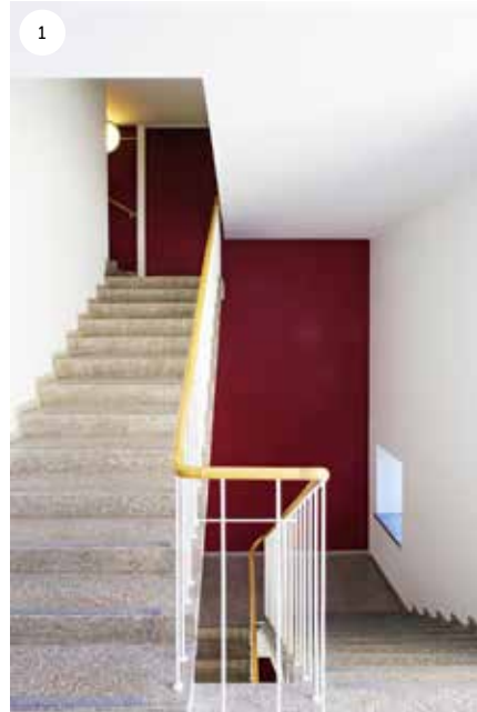
A-porras kuvattuna viidennen kerroksen kerrostasanteelta.
