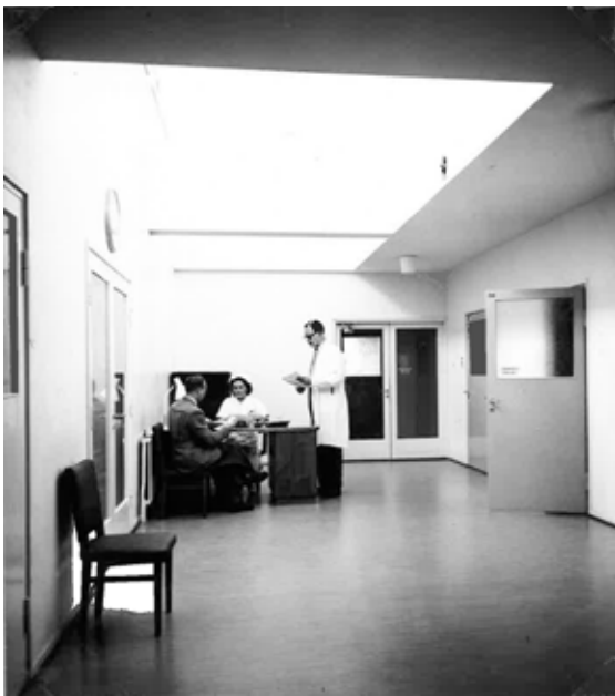
Lääketieteen osaston poliklinikan tilat vuonna 1951. Kuva on toisen kerroksen aulan viereisestä leveästä käytävätilasta, joka sai kattoikkunoista luonnonvaloa. TTL.
