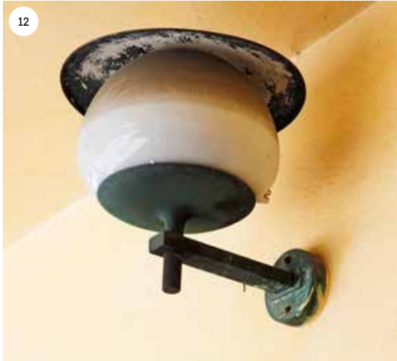
12 Topeliuksenkadun puoleisen sisäänkäynnin yhteydessä on säilynyt alkuperäisiä ulkovalaisimia, jotka on kiinnitetty seinään.
