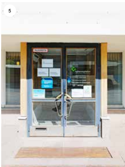
Työterveyslaitoksen vanhan osan pääsisäänkäynti sijaitsee Haartmaninkadun puolella syvennyksessä ja se on hyvin säilynyt. Pääovenä on alkuperäinen, kunnostettu teräsrakenteinen lasipariovi. Vetimet ovat alkuperäisiä. Oven ikkunoissa on puulistat. Tuulikaapin ikkunat ovat tammi-ikkunoita. Pääsisäänkäynnin edusta on laatoitettu graniittilaatoilla.
