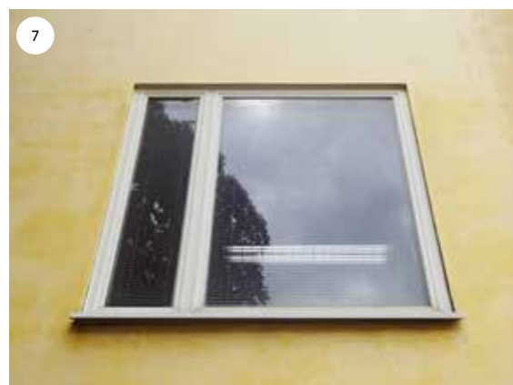
Osassa ikkunoita on uudet alumiinirakenteiset etuikkunat, jotka tulevat lähes julkisivupintaan. Ikkunapellit on uusittu.
