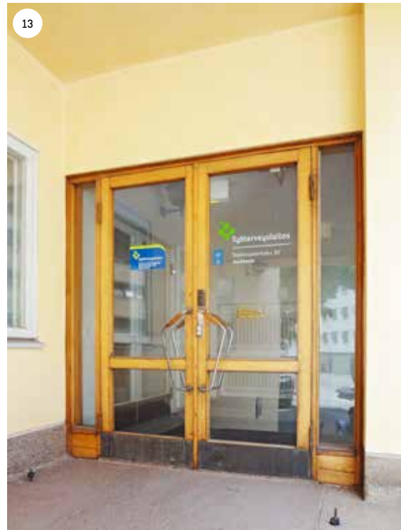
13 Topeliuksenkadun puoleinen sisäänkäynti on säilynyt alkuperäisessä asussaan. Ovet ovat ikkunallisia, lakattuja tammiovia, joiden alaosassa on kupariset potkupellit. Si- vuikkunat ovat tammea. Sisäänkäynnin edessä on graniittinen ulkoporras, joka sekin on alkuperäinen.
