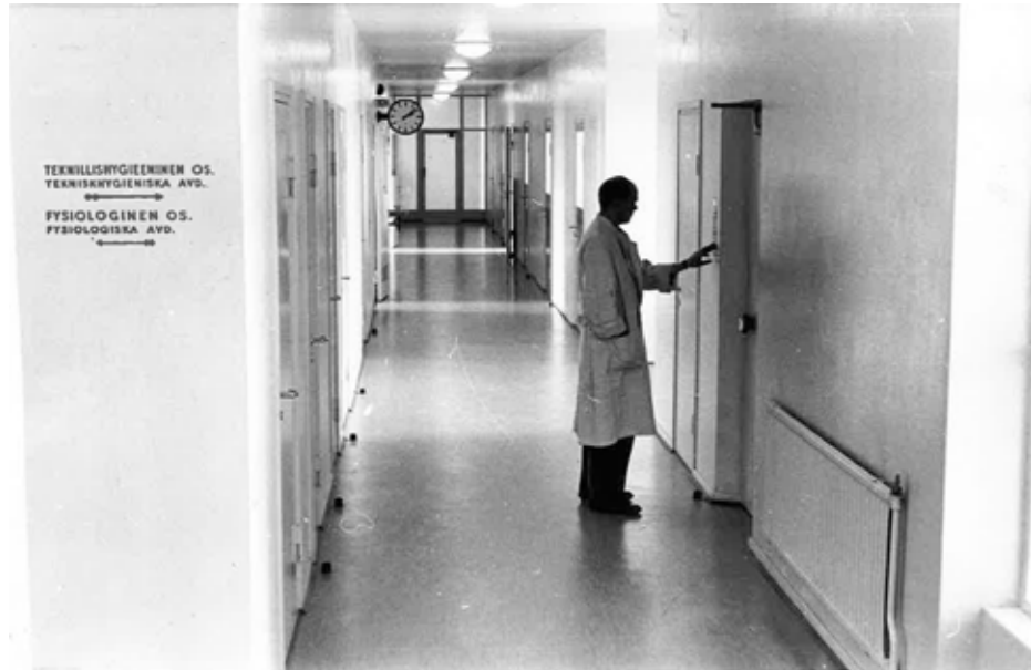
Teknillishygieenisen osaston käytävä uudisrakennuksen ensimmäisessä kerroksessa hohti hygieniaisyyttä. Käytävät olivat leveitä kattoon oli kiinnitetty pyöteitä valaisimia. Ovet olivat pääosin ikkunallisia puuovia. Kuva on vuodelta 1951. TTL.
