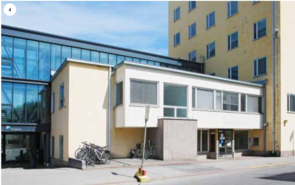
Vuonna 2003 valmistunut Työterveyslaitoksen laajennusosa on kiinni vanhassa osassa. Teräslasirakenteinen yhdyskäytävä nousee osittain vanhan rakennuksen matalan osan päälle. Laajennusosan pääsisäänkäynti näkyy kuvassa vasemmalla ja vanhan osan sisäänkäynti on valkoiseksi maalatun osan alapuolella.
