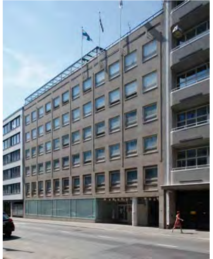
KHO:n Unioninkatu 16:n julkisivu kadulle kuvattuna vuonna 2013. Julkisivun metalliset vaakalistat on purettu ja katutason ovet on poistettu. 7. kerroksen parveke osittain lasitettu 2011. Naapuritalo on korvautunut modernilla toimistorakennuksella.
