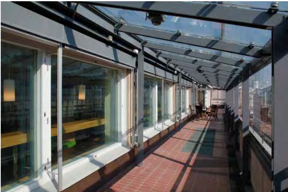
7. kerroksen terassi lasitettiin osittain. Kattoterassi liittyy vasemmalla näkyvään kirjastotilaan. Tiloissa sijaitsi ennen henkilöstöravintola, joka vuonna 2010 tapahtuneen tulipalon jälkeen remontoitiin kirjastoksi vuonna 2011. Kuva on otettu keväällä 2013.
