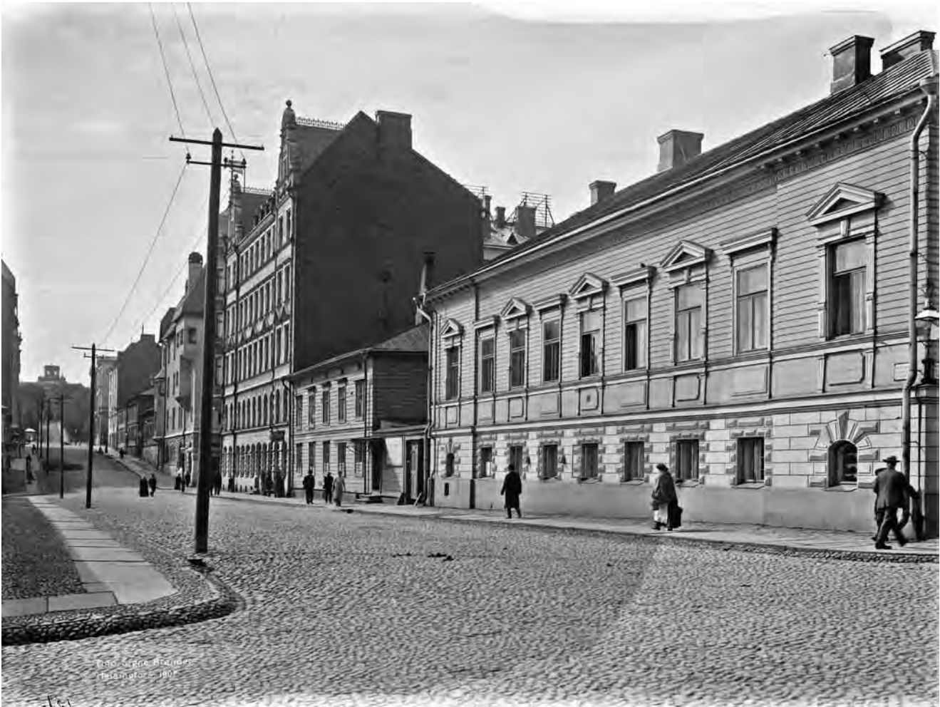
Unioninkadun katunäkymä tähtitornin mäelle päin vuonna 1907. Toinen rakennus oikealta on Unioninkatu 16:a aiemmin sijainnut kaksikerroksinen puutalo, jonka piirustukset on päivätty heinäkuussa 1857. Kuvaaja Signe Brander. HKM KA.
