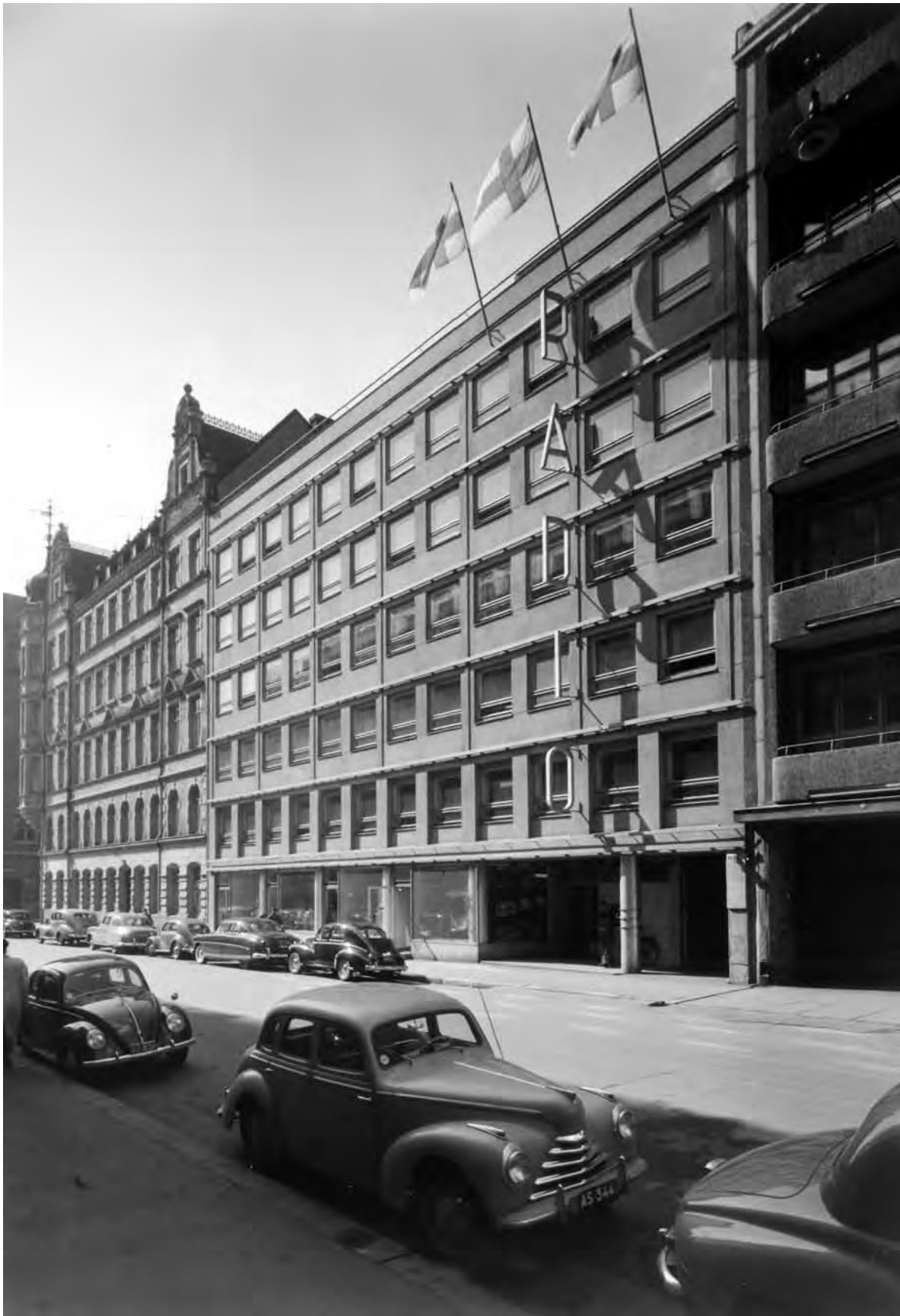
Yleisradion radiotalo Unioninkatu 16:ssa kuvattuna vuonna 1953. Julkisivussa lukee teksti Radio. Kuvaaja Aarne Pietinen. Yle Kuvapalvelu.
