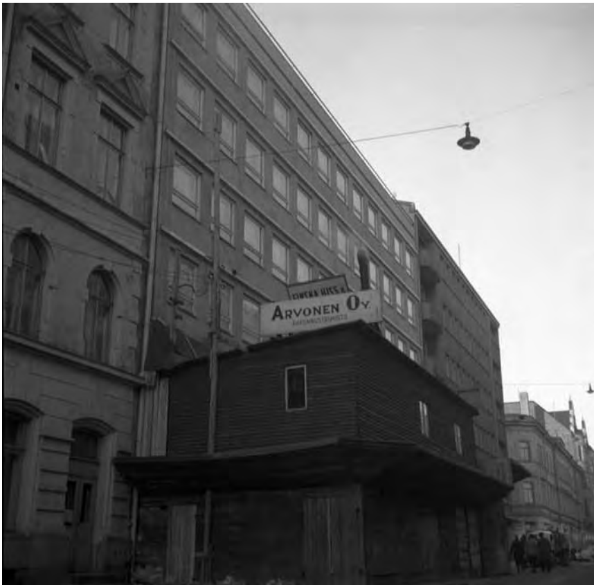
Unioninkatu 16:n katujulkisivu rakennustöiden aikana 22.1.1952. Urakoitsijana toimi rakennustoimisto Arvonen Oy. Kuvaaja Ruth Träskman. Yle Kuvapalvelu.
