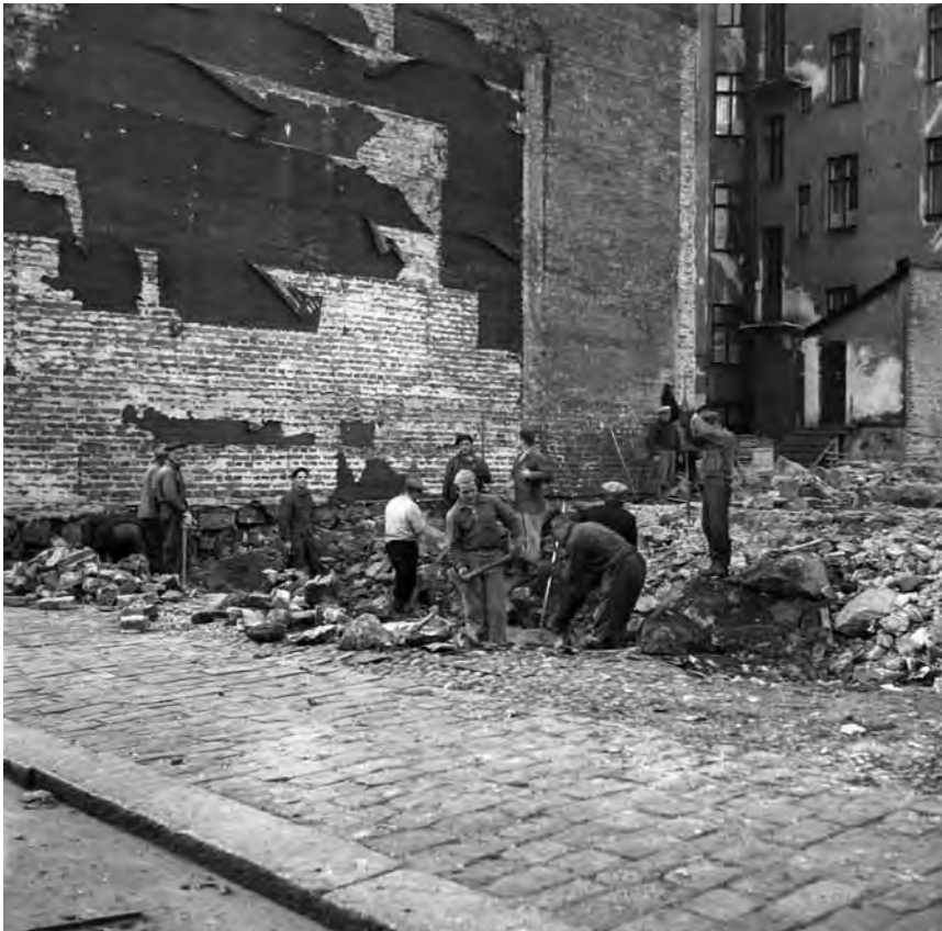
Yleisradion käyttöön tulevan Unioninkatu 16:n toimitalon rakennustyömaa 16.10.1950. Aiemmin paikalla sijainneet puutalot ja kivinen piharakennus on purettu ja uuden rakennuksen perustuksia kaivetaan. Kuvaaja Ruth Träskman. Yle Kuvapalvelu.
