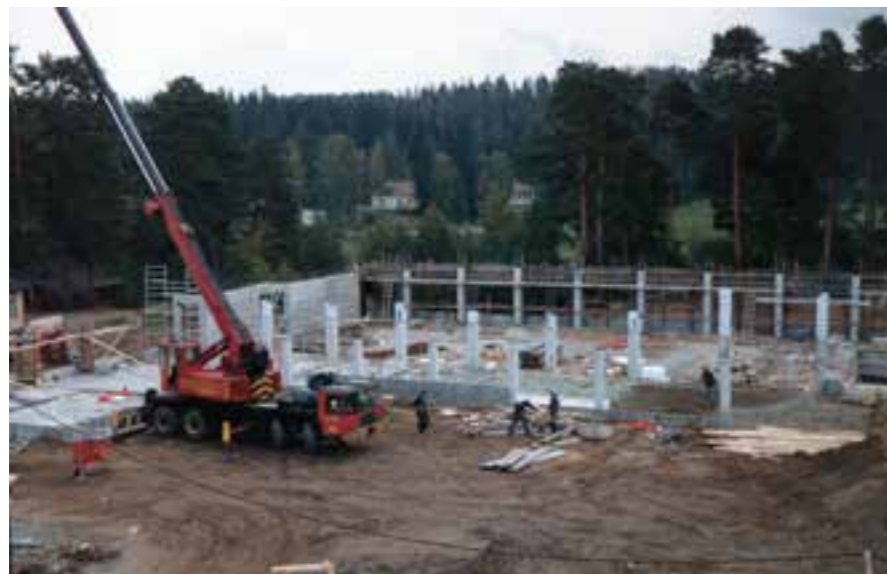
Salirakennuksen työmaalta vuonna 1984. (Tekninen huolto, Niuvanniemen sairaala)
