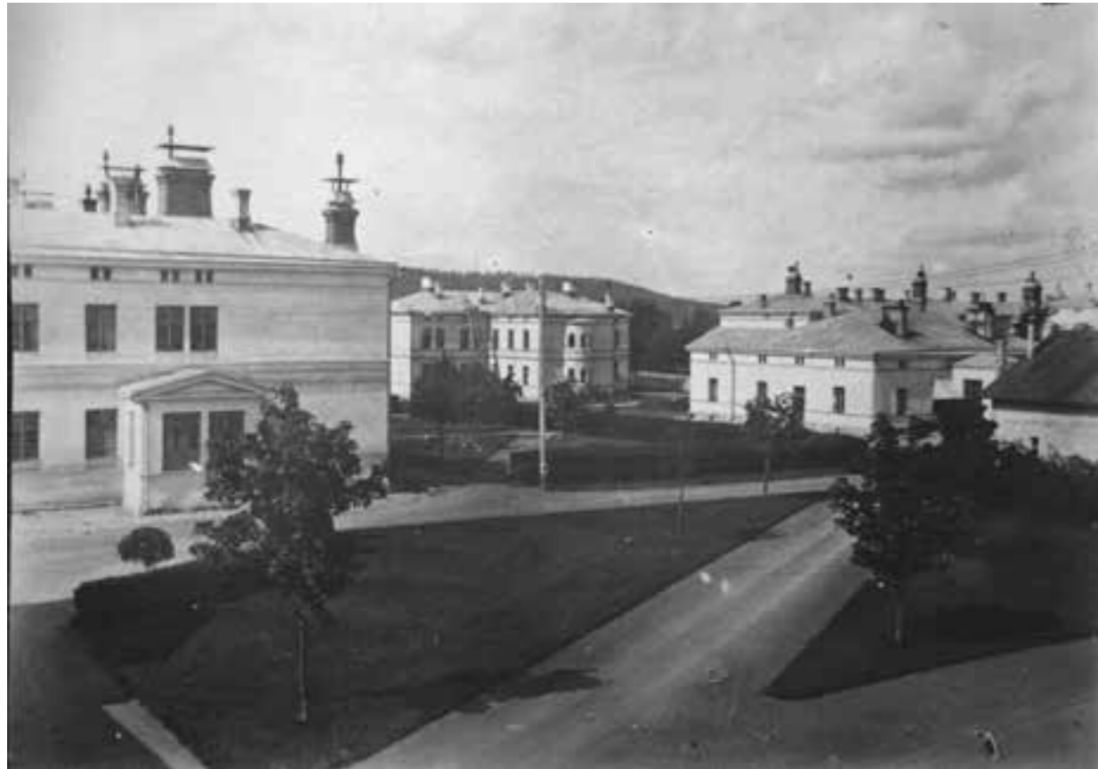
Sairaalan keskuspihalle tehtiin viihtyisät istutukset ja nurmialueet. (NIUSK)
