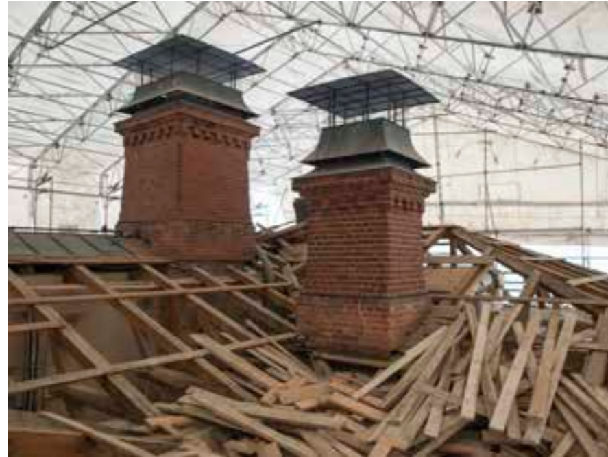
Vasemmalla imuپیپут osaston 1-2 katolla vesikaton korjaustyön aikaan. Imuپیپут on edelleen säilynyt jokaisen potilasosaston katolla, vaikka osa piipuista onkin purettu.
