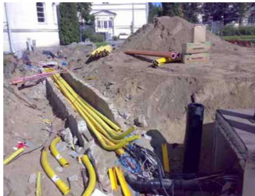
Putkikanaalit sairaalan alueella uusittiin vuonna 2013. (Tekninen huolto, Niuvanniemen sairaala)
