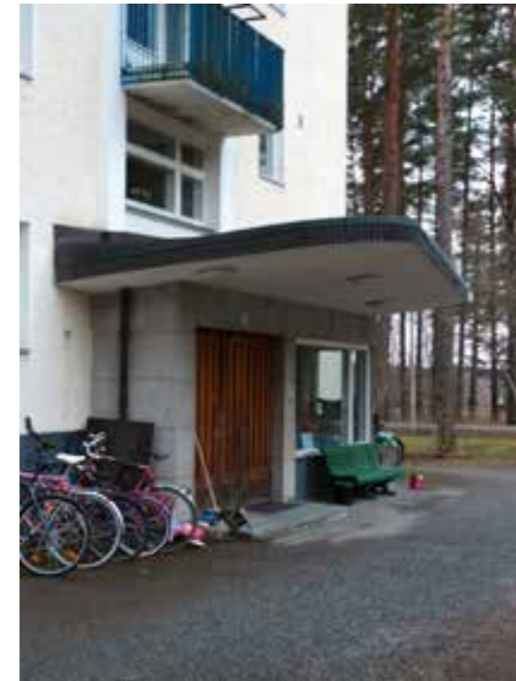
Asuinrakennus E:n hienoa detajointia ja julkisivun erilaisia pintakäsittelyjä.
