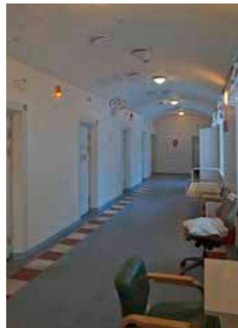
115 a Käytävä. Kaareva kipsilevyalakatto 1990-luvulta.
