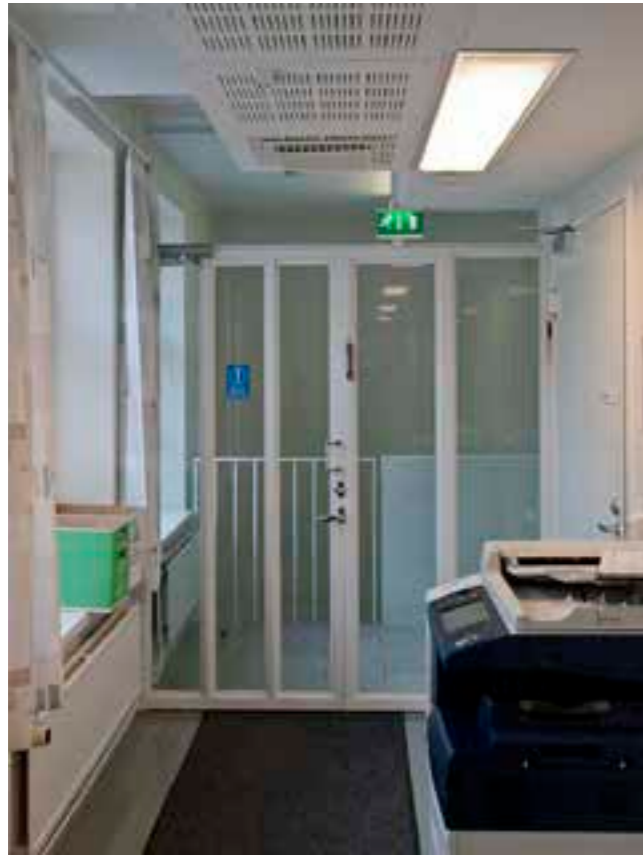
202 Käytävä Teräsrakenteinen ikkunaovi 1990-luvulta porrashuoneeseen 201.
