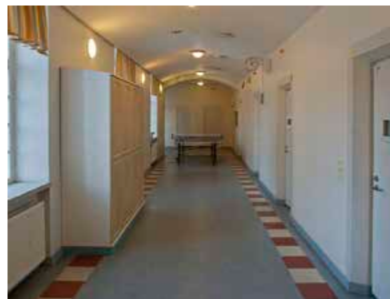
219 a Käytävä. Kaareva kipsilevyalakatto 1990-luvulta.
