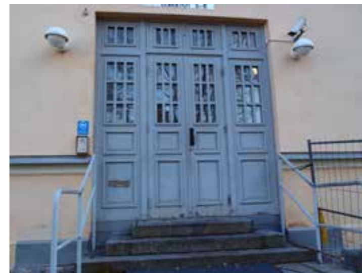
Länsisivulla oleva rakennuksen pääovi. Ovi on uusittu kokonaan 1960-luvulla, mutta noudattaa jäsentelyltään alkuperäistä mallia.
