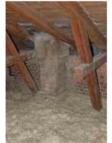
236 Ullakko. Siipiosassa vesikatto runkorakenteineen on uusittu. Alkuperäisiä hormistoja on osittain purettu. Yläpohjassa on alkuperäinen rataiskojen varaan tehty kappaholvaus. Alkuperäiseen rakenteeseen kuuluu myös hirsipalkkeja.
