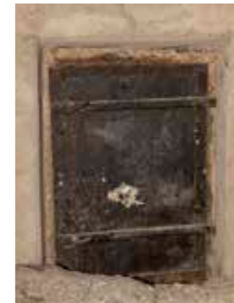
300 c Ullakko. Imupiipun huoltoluukku.
