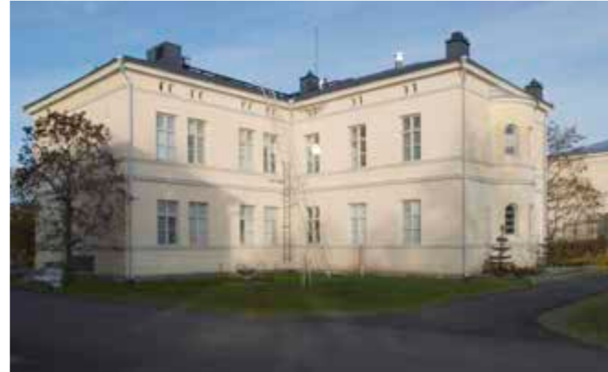
Hallintorakennuksen eteläsivut nähtynä kaakosta.
