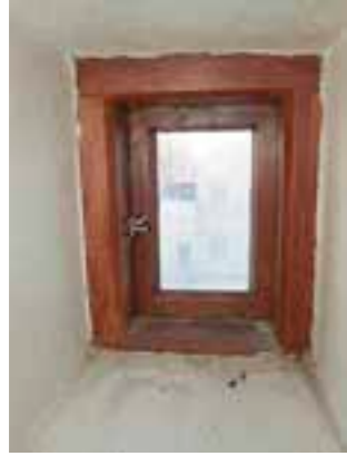
300 a Ullakko. Alkuperäinen ikkuna.
