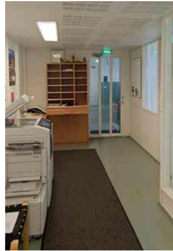
202 Käytävä Teräsrakenteinen ikkunaovi 1990-luvulta aulaan 215
