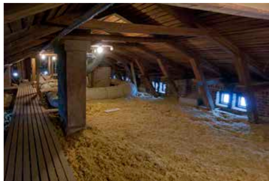
300 B Ullakko. Kattorakenne ja piiput alkuperäisiä.
