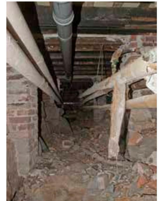
Puurakenteista alapohjaa. Uusi muoviviemäri kylmässä alapohjan tilassa.
