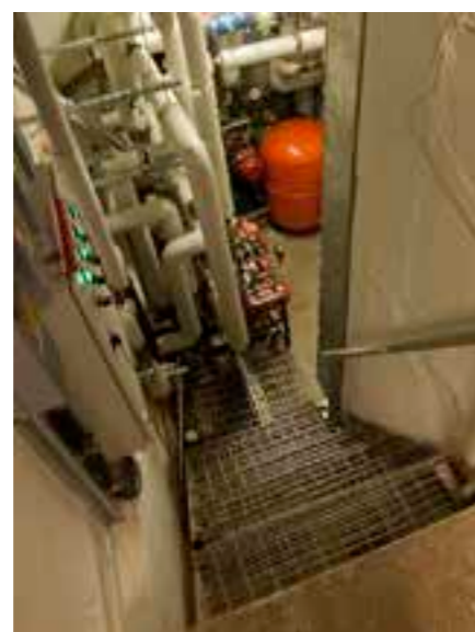
131 Tekninen tila. Lämmönjakolaitteiden tila on tehty alapohjan tilaan. Oikealla : Sähköpääkytkin 1930-luvulta.
