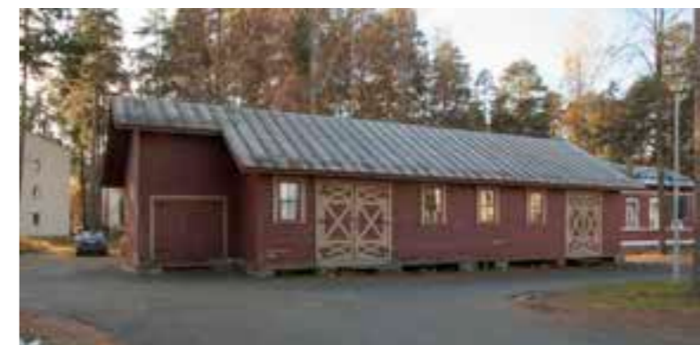
Kiikkukankaan ulkorakennus nykyisin, vasemmalla luoteesta, alla pohjoisesta.
