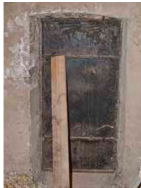
300 c Ullakko. Imupiipun alkuperäinen luukku.
