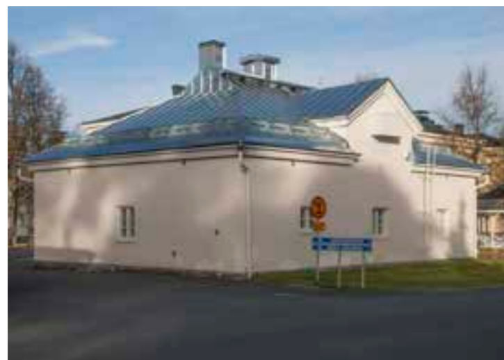
Potilassauna nykyisin. Rakennuksen vesikatto uusittiin vuonna 2013.
