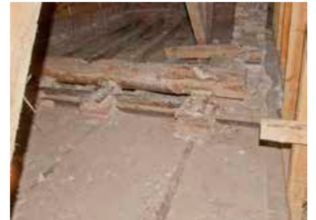
236 Ullakko. Siipiosassa vesikatto runkorakenteineen on uusittu. Alkuperäisiä hormistoja on osittain purettu. Yläpohjassa on alkuperäinen rataiskojen varaan tehty kappaholvaus. Alkuperäiseen rakenteeseen kuuluu myös hirsipalkkeja.
