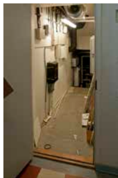
131 Tekninen tila. Lämmönjakolaitteiden tila on tehty alapohjan tilaan. Oikealla : Sähköpääkytkin 1930-luvulta.
