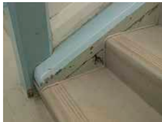
130 Porras. Alkuperäinen puurakenteinen porras on osittain peittyneenä uusiin pintarakenteisiin.
