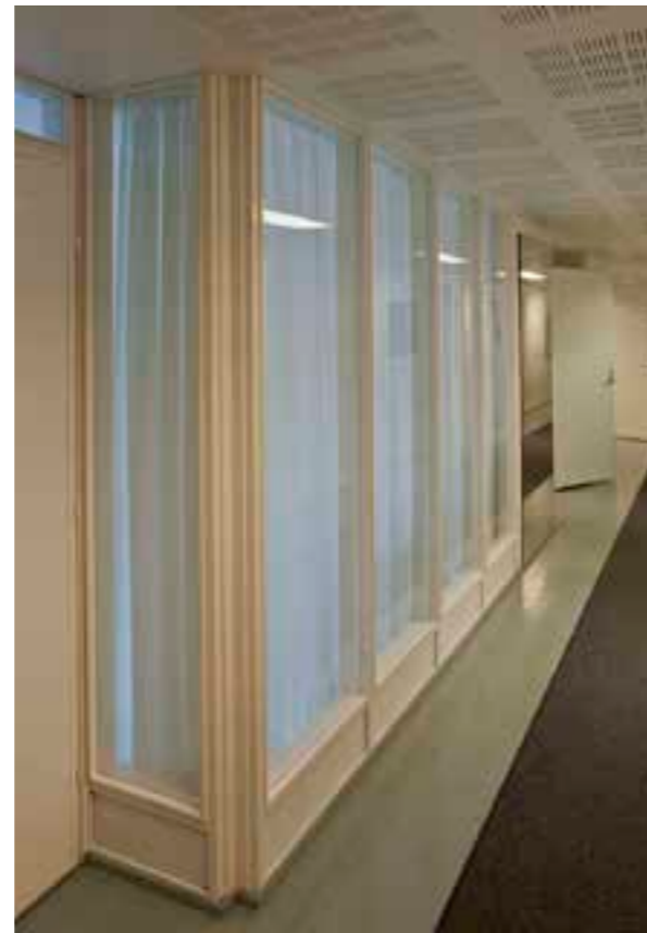
202 Käytävä Toimistosiiiven käytävään henkilökunnan kahviosta avautuva väliseinäikkuna 1990-luvulta.
