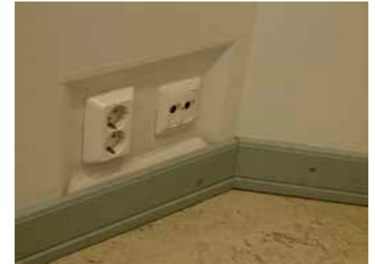
Pistorasiat on upotettu seinäpinnasta sisään. Jalkalista on 1990-luvulta.
