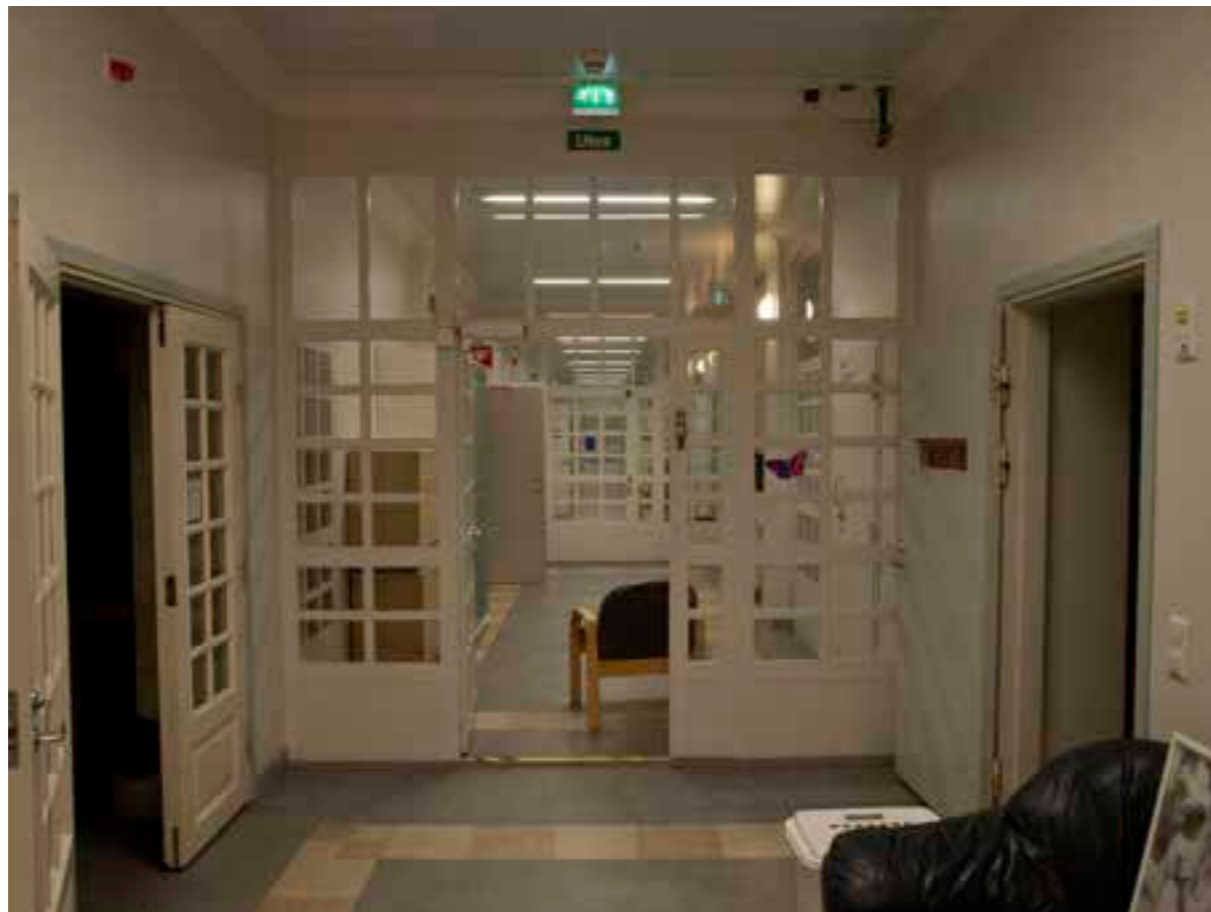
100d Käytävä. Läpi rakennuksen jatkuvassa käytävässä on 1990-luvulla toteutettuja, osastoja erottavia ikkunallisia oviseiniä.
