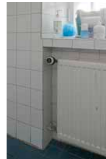
147 Pesuhuone. Huolellisesti viimeisteltyjä laatoituksia 1990-luvulta. Liittymissä on käytetty muotokappaleita
