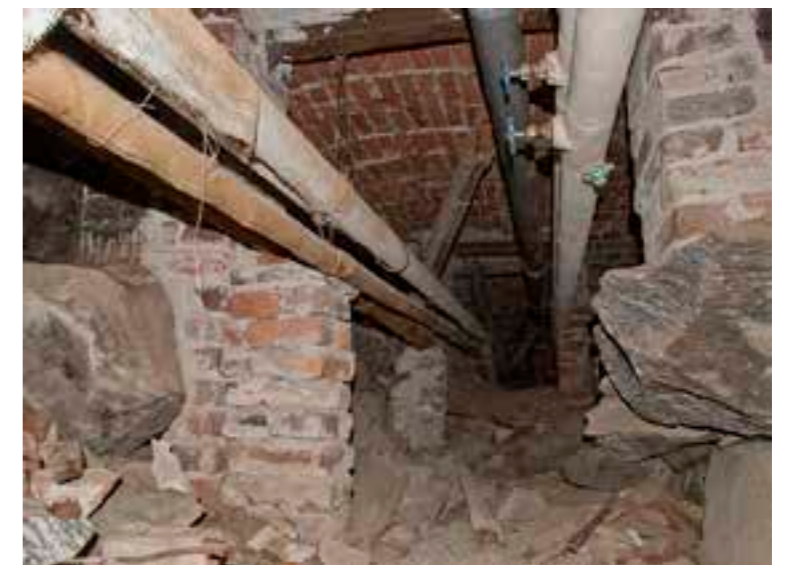
Alkuperäistä tiiliholvattua alapohjaa. Putkistot 1930-luvulta. Putkieristykset asbestia.
