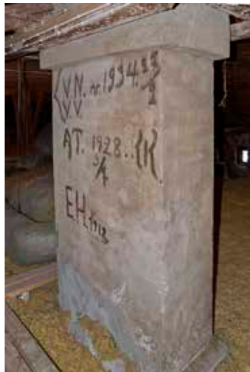
300 b Ullakko. Todennäköisesti korjaustöihin liittyviä merkintöjä.
