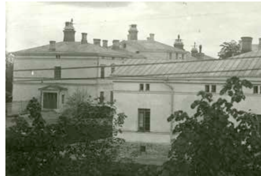
Rakennus vuosina 1922-1923 tehdyn pienen muutoksen jälkeen. Rakennuksen keskiosassa näkyy korotus, jolla ullakolle saatiin lisähuoneita sairaanhoitajaopiskelijoiden majoittamiseen. Etualalla osa keittiörakennusta. (KUHMU; osa kuvasta)
