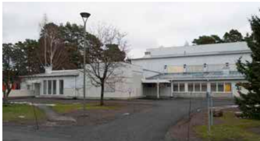
Vasemmalla yllä Salirakennus, alla rakennusryhmä pohjoisesta. Alla Terapiarakennuksen julkisivua.
