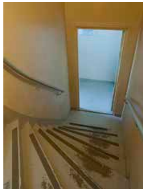
133 Porras. Betonirakenteinen porras 1960-luvulta.
