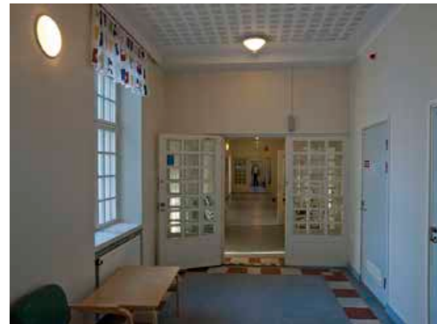
115 a Käytävä. Käytävät 1990-luvun kunnostustöiden asussa. Alakatto on reiätettyä kipsilevyä.
