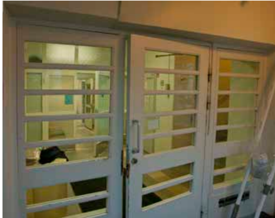
100g Kuisti. Ikkunaovet on uusittu 1960-luvulla. Kuva katsottu kuistilta käytävään 100 f.
