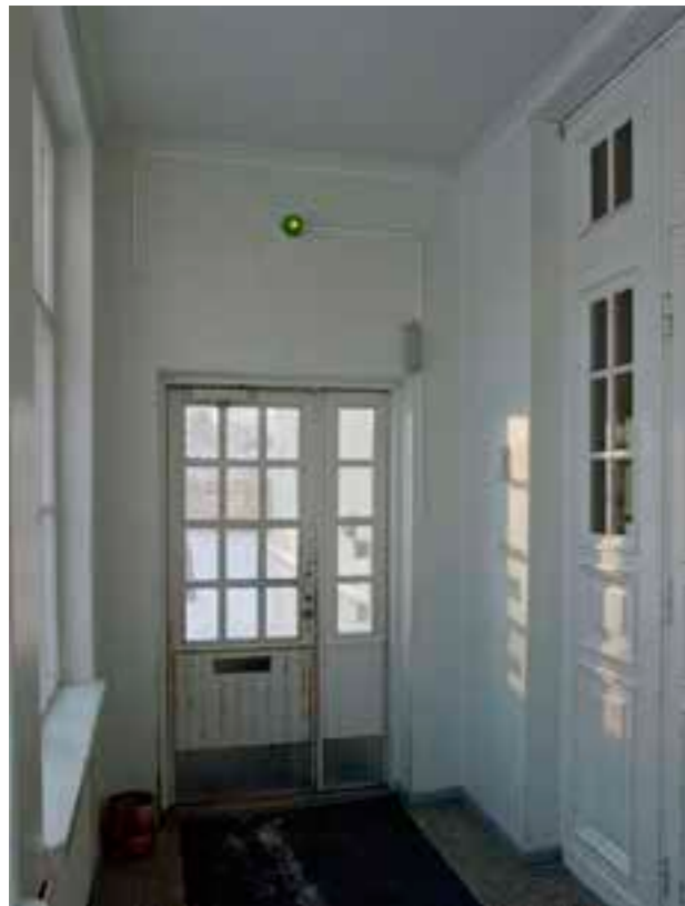
159 Kuisti. Nykyisin pääsisäänkäyntinä oleva kuisti. Ulko-ovi on uusittu 1960-luvulla. Oikealla sairaalaosastolle johtava ikkunallinen väliovi on alkuperäinen.
