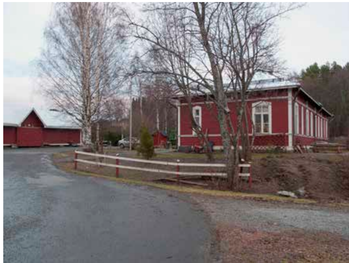
Asuinrakennus R lännestä nähtynä, vasemmalla Pesulanrannan siipiosa.
