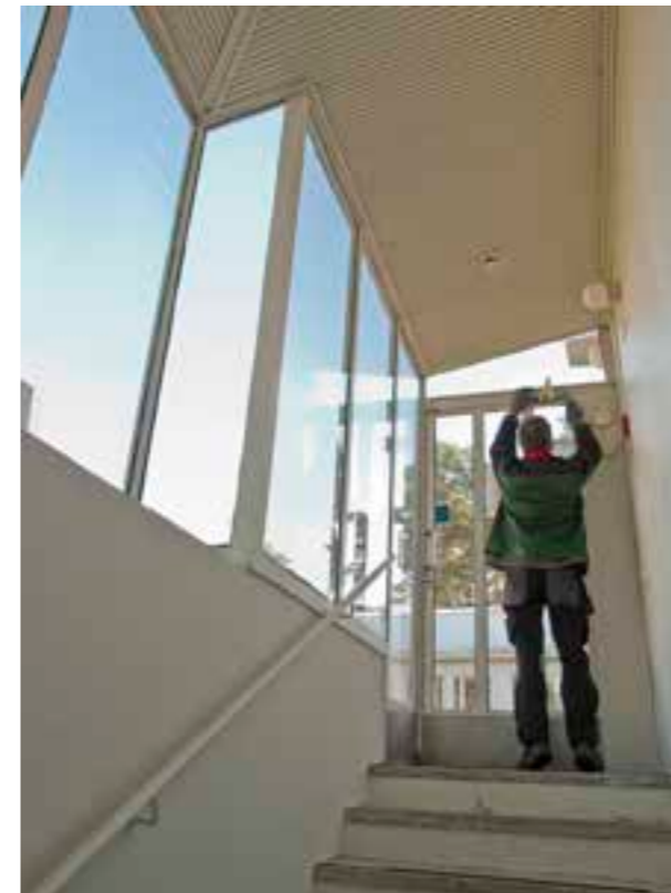
006 Eteinen Avoporras on katettu ja lasitettu 1990-luvulla.
