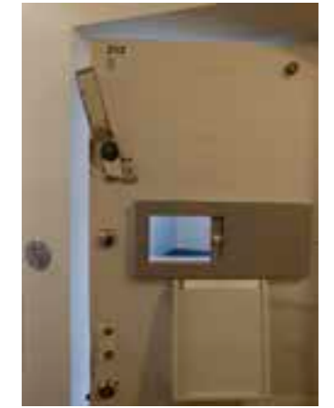
212 Eristys. Oven salvat ja ikkuna.
