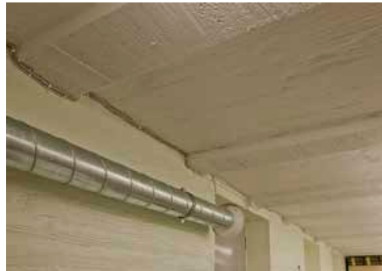
009 Arkisto. Alkuperäinen alapohjan kappaholvirakenne on muutettu teräsbetonirakenteeksi.
