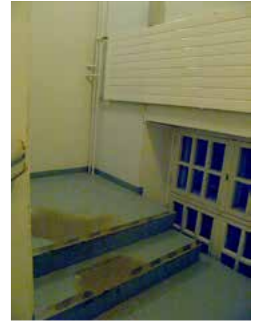
113 b Porras. Alkuperäisen portaan puurakenne on korvattu 1960-luvulla betonirakenteella. Porrashuoneessa ikkunat jatkuvat välitasanteelta toiselle
