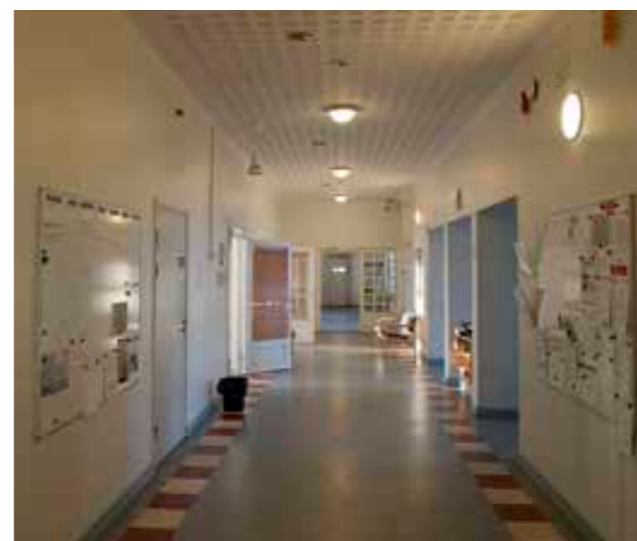
219 Käytävä. Uritettu kipsilevyalakatto 1990-luvulta.
