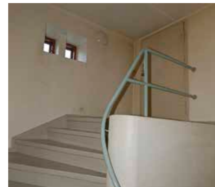
133 Porras. Betonirakenteinen porras 1960-luvulta.
