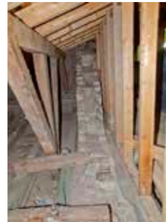
236 Ullakko. Siipiosassa vesikatto runkorakenteineen on uusittu. Alkuperäisiä hormistoja on osittain purettu. Yläpohjassa on alkuperäinen rataiskojen varaan tehty kappaholvaus. Alkuperäiseen rakenteeseen kuuluu myös hirsipalkkeja.
