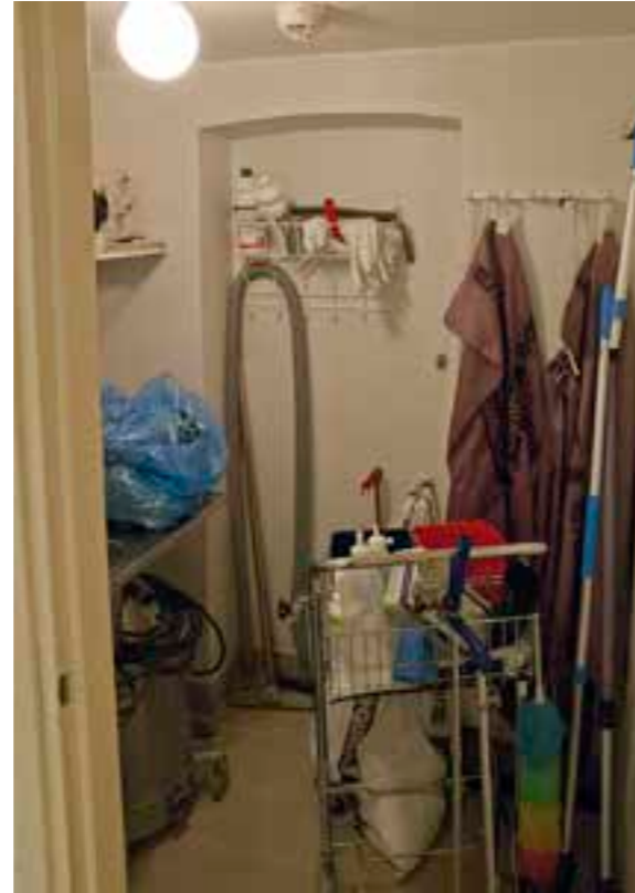
010-2 Siivous Kuvassa taustalla umpeen muurattu alkuperäinen oviaukko.
