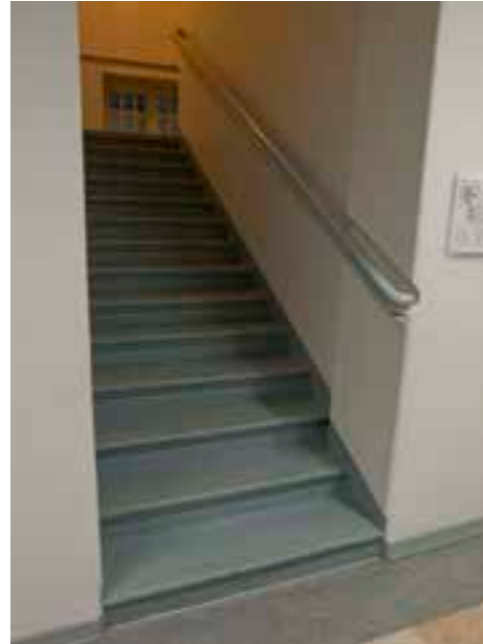
101 Porras. Alkuperäinen puurakenteinen porras ja käsijohde.
