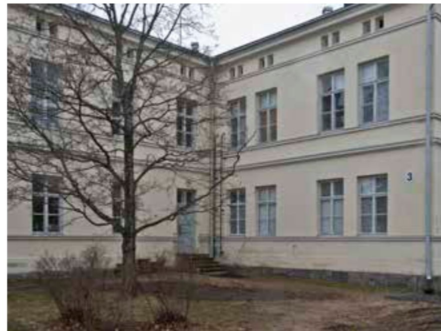
Rakennuksen koilliskulmauksessa oleva ovi avattiin 1960-luvun lopulla tehdyissä muutoksissa.
