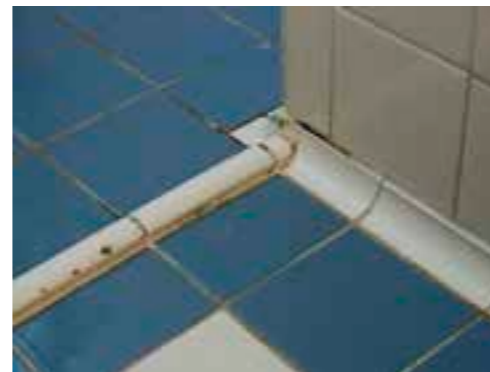
147 Pesuhuone. Huolellisesti viimeisteltyjä laatoituksia 1990-luvulta. Liittymissä on käytetty muotokappaleita
