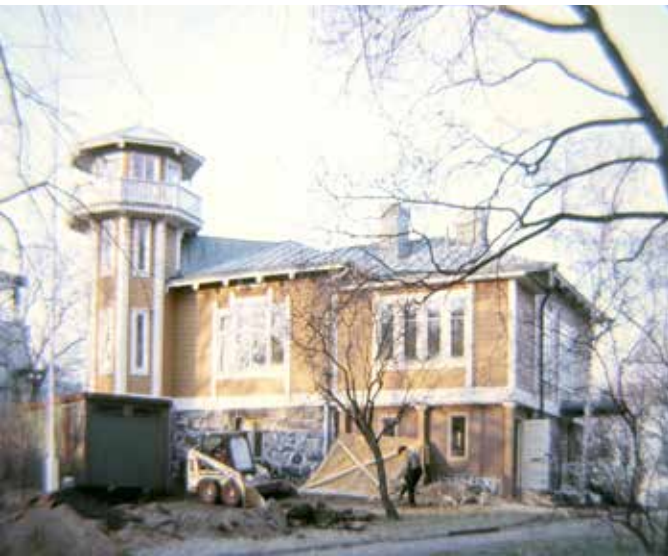
Galleriarakennus peruskorjauksen aikana, ennen talonmiehen eteisen levyseinien laudoittamista. Pietarila / MV
