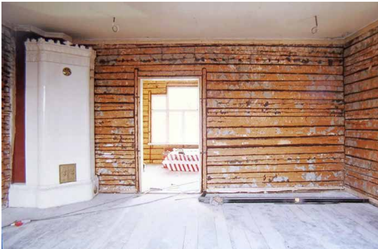
Yläkerran sali 106 peruskorjauksen aikana. Pietarila / MV
