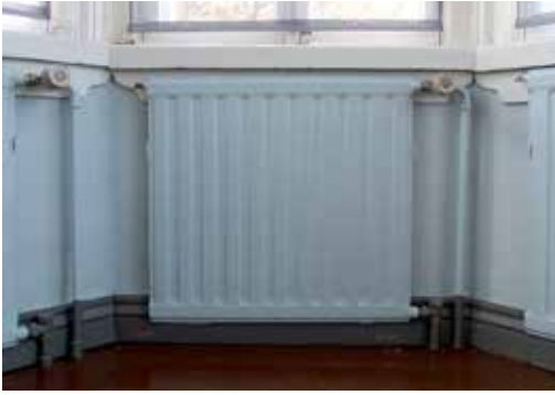
Pystysuuntaan uritettuja levypattereita vuodelta 1959 on pohjakerroksen huoneessa 011 ja wc:ssä 008 sekä kaikissa yläkerran huoneissa.
