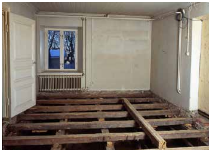
Keittiö alapohjan purkamisen aikaan vuonna 2007. Tirilä / MV
