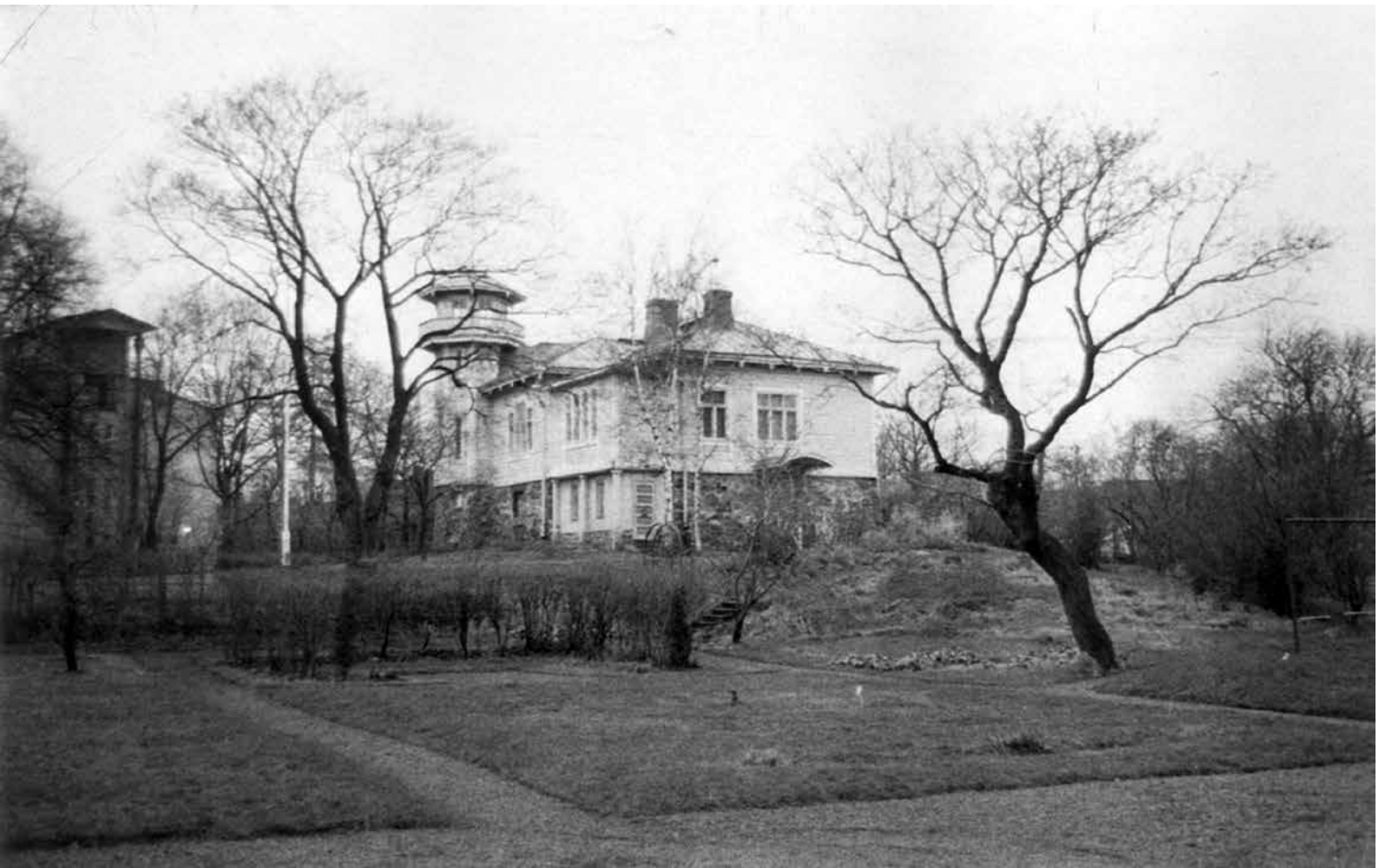
Näkymä Kalliolinnan pihalta 1970-luvun vaihteessa, ennen asuinkerrostalon rakentamista. Hämäläinen / CGA
