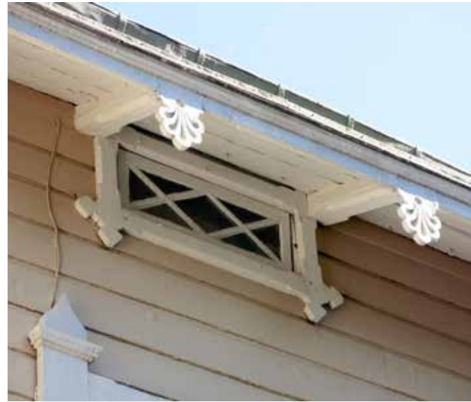
Ullakkoikkunat ovat alkuperäisiä vuodelta 1870. Seitsemiruutuiset ikkunat on kiinnitetty seinähirsiin sormihaoilla ilman karmia.
