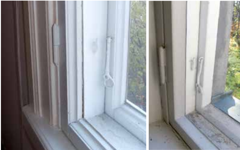
Ullakkoikkunat ovat alkuperäisiä vuodelta 1870. Seitsemiruutuiset ikkunat on kiinnitetty seinähirsiin sormihaoilla ilman karmia.
