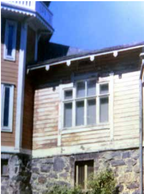
Lähes puupinnalle kaavitut seinät kesällä 1989. Weckman / CGA
