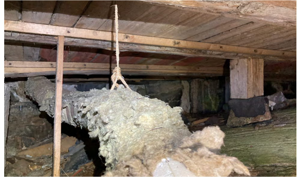
Luotsituvan alapohja vaikutti ehjältä ja kuivalta. Kuvan etualalla keskuslämmityksen putki.
