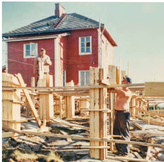
Parakkisiiven perustusten muottitöitä elokuussa 1969. Merenkululaitoksen valokuvat, Väyläviraston arkisto.
