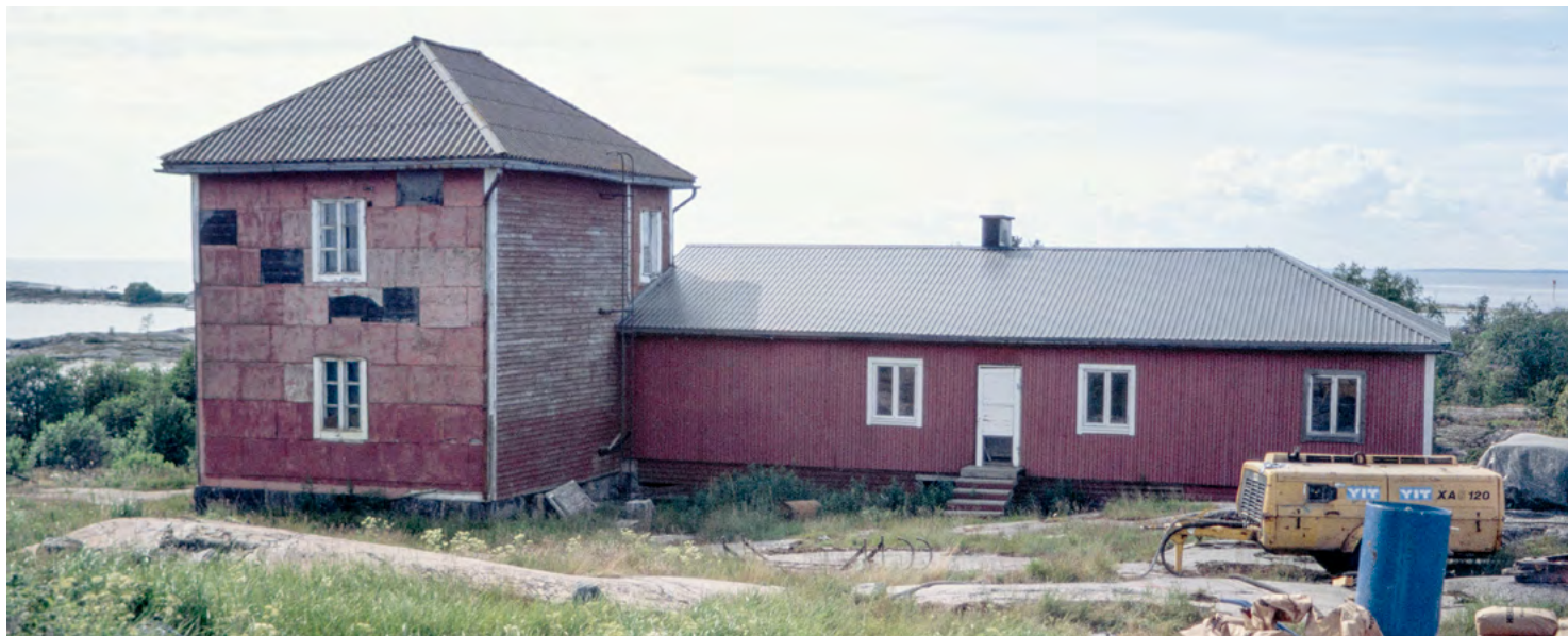
Luotsiasema pohjoisesta kuvattuna vuonna 2000. Koillisseinässä on mineriittilevyjen sijasta lautavuoraus. Pekka Sihvonen, Rakennushistorian kuvakokoelma Museovirasto.
