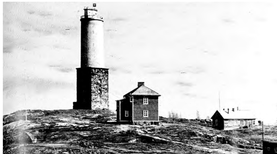
Luotsitupa 1950-luvun lopulla. Alkuperäiset T-karmi-ikkunat on vaihdettu kuusiruutuisiin ikkunoihin. Kuistin toisen sisäänkäynti on poistettu ja sen tilalle on vaihdettu uusi ikkuna. Gunnar Nordströmin kotialbumi.
