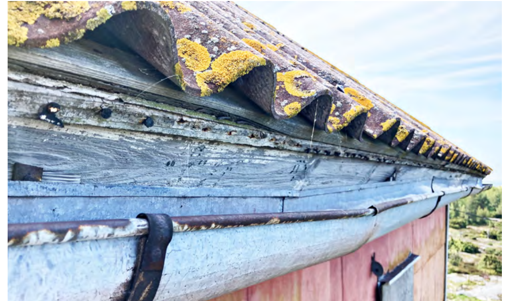
Luotsituvan räystäärakennetta ja varttikatteen reunaa rakennuksen koillisseinällä.
