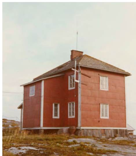
Luotsitupa kunnostettuna todennäköisesti 1960-luvun alussa tai puolivälissä. Merenkululaitoksen valokuvat, Väyläviraston arkisto.
