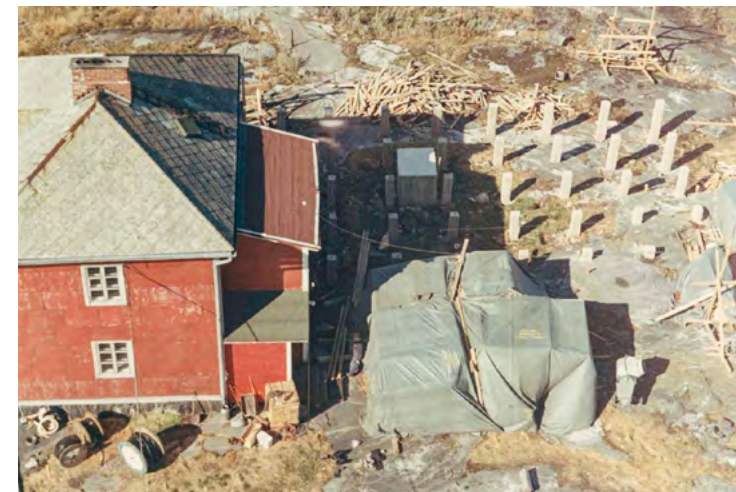
Luotsitupa ja parakkisiiven perustukset majakkatornista kuvattuna syyskuussa 1969. Etualalla näkyy kuistin kylkeen vuonna 1968 rakennettu tuulikaappi. Kuisti purettiin kokonaisuudessaan osana parakkisiiven rakennustöitä. Merenkululaitoksen valokuvat, Väyläviraston arkisto.
