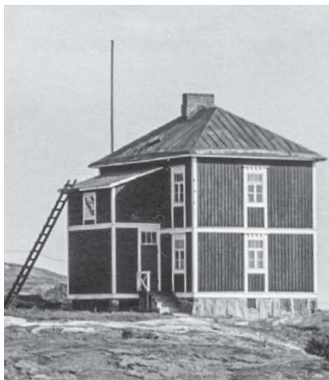
Tuore luotsitupa. Valokuvan perusteella asema vastaa melko tarkasti vuoden 1917 piirustuksia. Suuri ero on ikkunoissa, jotka ovat 9-ruutuisten sijaan T-karmi-ikkunoita. Kuva Nuori Luotsi elokuvan kuvauksista, KAVI / Suomi-Filmi Oy.
