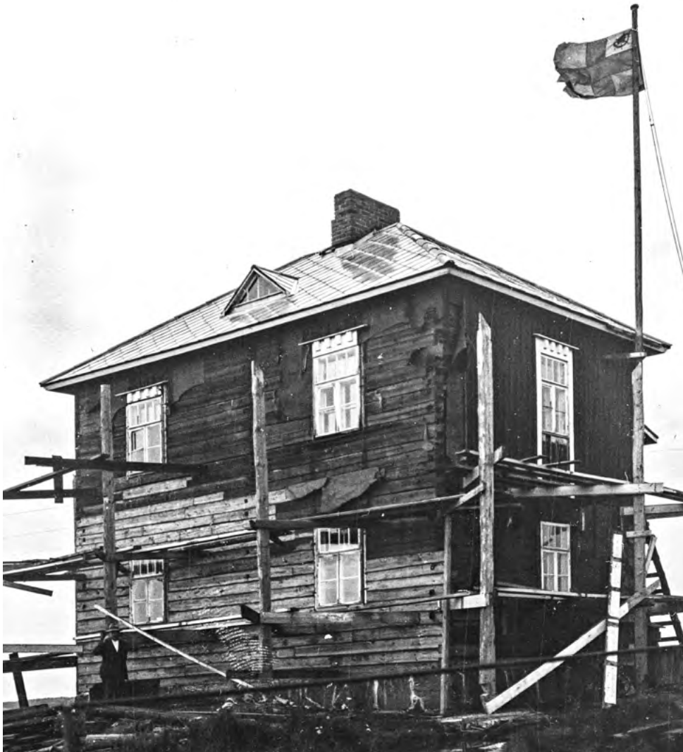
Vesikate on vaihdettu ja lounaissivun ulkovooraus purettu kokonaan. Alaosan uudet, vaaleat hirret on asennettu pulteilla. Kuva lienee vuodelta 1929 tai 1930. Luotsi- ja majakkalaitoksen arkisto, Kansallisarkisto.
