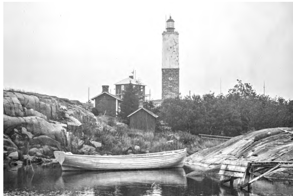
Näkymä Rönnskärin venerannasta kohti majakkaa ja asuinrakennuksia kesällä 1929 tai 1930. Majakan lyhtykoju on yhä paikoillaan, ja luotsituvan ympärillä on rakennustelineet. Luotsi- ja majakkalaitoksen arkisto, Kansallisarkisto.
